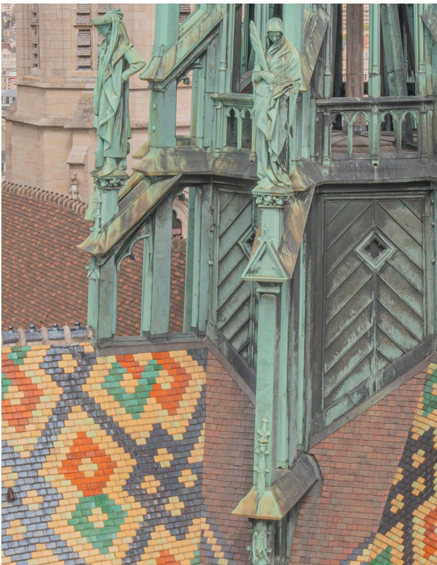
Décors sur les poteaux de contreforts diagonaux et d'axe : pinacles en partie basse, pinacles alternant avec des gâbles sous les socles à feuilles de vigne des statues, redents entre poteaux. Cliché pris par drone.
