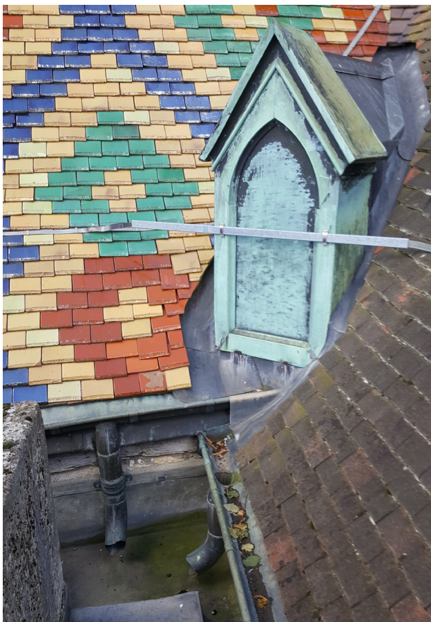
Lucarne nord-ouest : devanture en cuivre, toiture en zinc, noues en plomb. Passage du feuillard à l'avant. Évacuations EP en pied.
