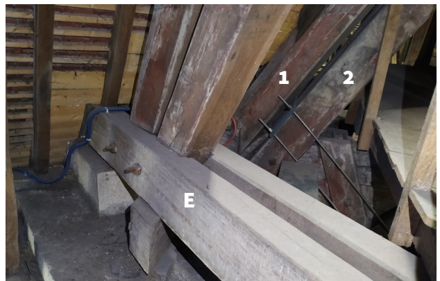
E/ Entrait de la ferme périphérique nord reposant sur un dé en pierre et sur le gousset de l'entrait diagonal nord-est. Arrière-plan : 1/ chevron de noue - 2/ arbalétrier moisé diagonal
