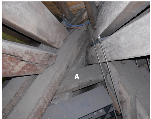
A/ Gousset d'angle entre les entrails des fermes périphériques assemblé au brin supérieur de la poutre-entrait diagonale.
