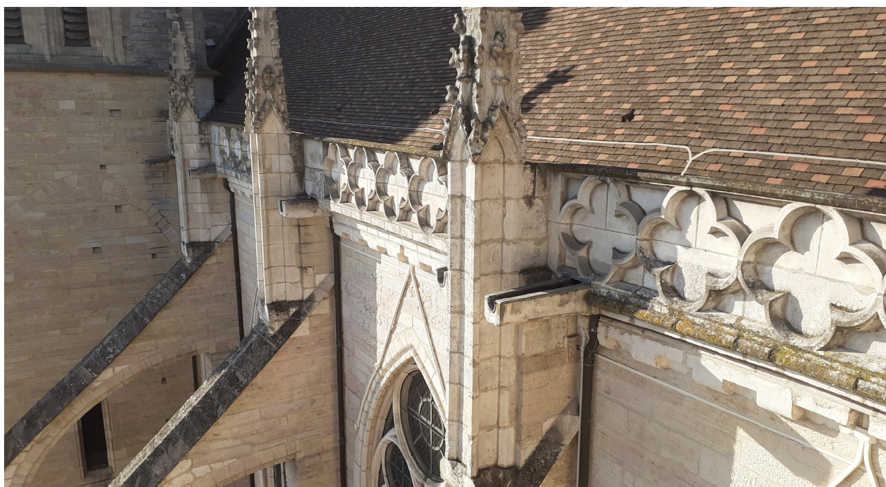
Vue projet du pied de versant sud de la nef : cheminement de la descente du paratonnerre au travers du chéneau
