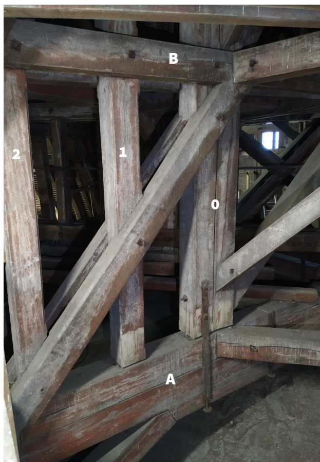
Ferme diagonale nord-ouest entre les enrayures 1 et 2. O/ Double-poteau de fût, poteaux de contrefort 1 et 2. A/ Poutre-entrait - B/ Entrait moisé
