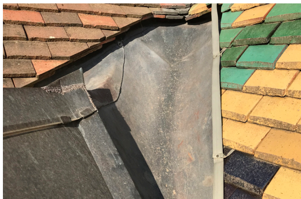
Détail du démarrage de la noue en plomb au-dessus de la lucarne sud-ouest.
