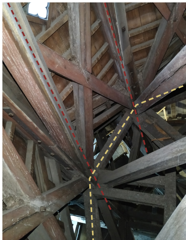
Poteaux de fût et croix de St-André formant le fût entre les enrayures 3 et 4. Repérage de l'octogone en jaune et des poteaux en rouge.
