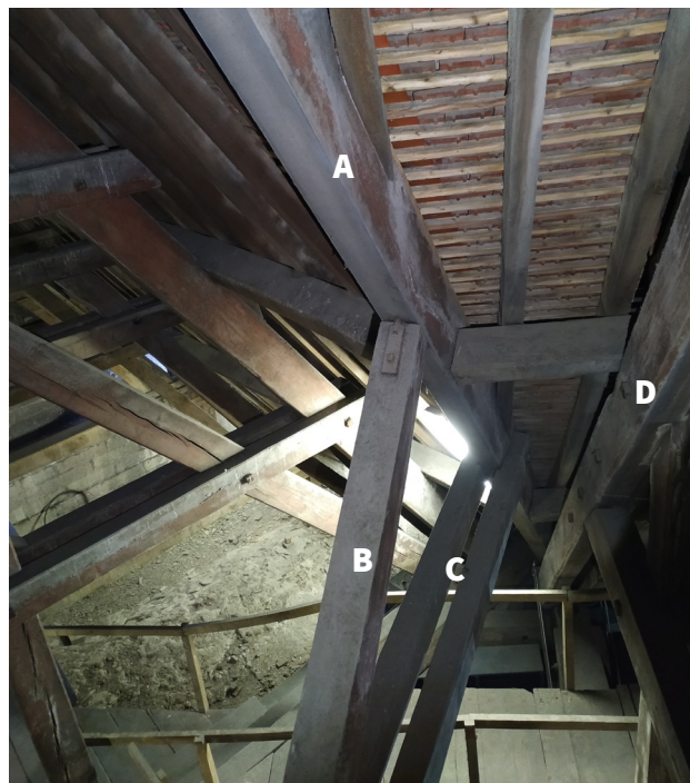
A/ Chevron de noe SSO contrebuté par une contrefiche de noe B et un coyer de noe C. D/ Arbalétrier SO
