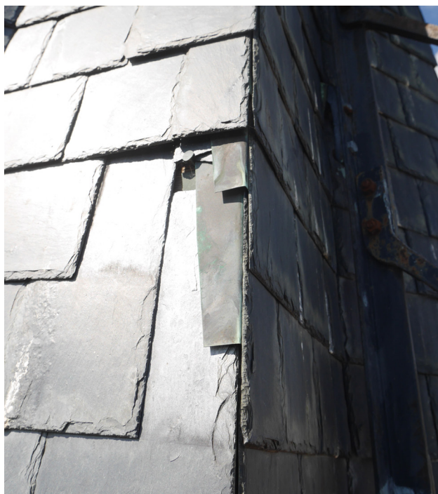
Bandes d'arêtier en cuivre
