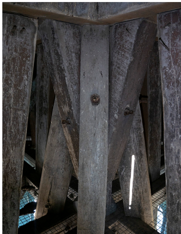
Nœud d'assemblage autour du poinçon, au niveau de l'enrayure 5.
