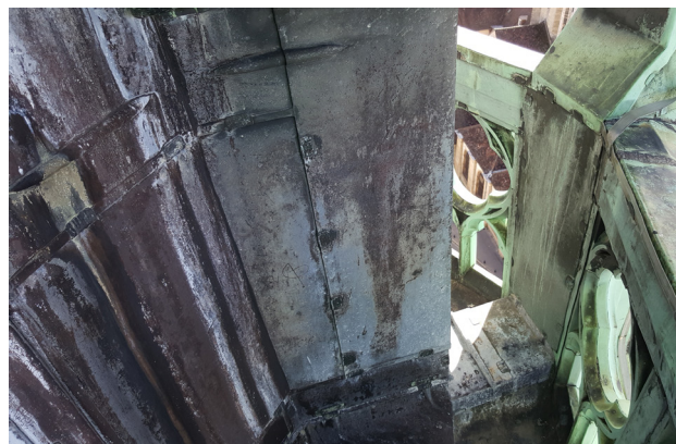
Détail du recouvrement en plomb d'un poteau de contrefort et du chéneau.
