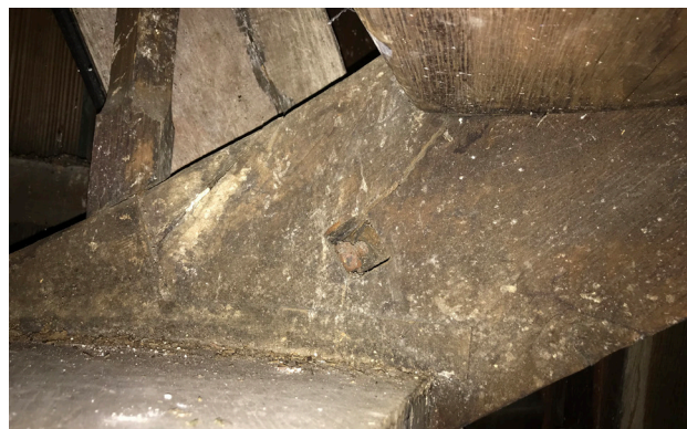
Assemblage du limon à crochet, serré par tige filetée.
