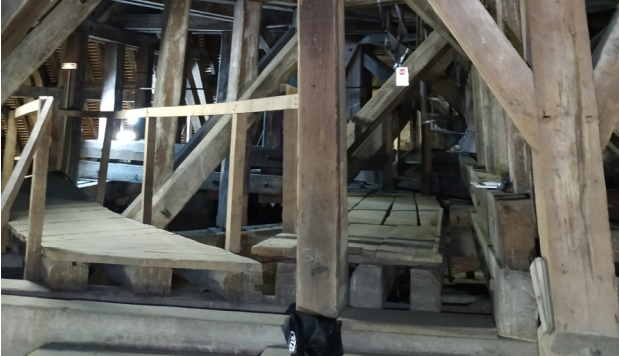
Passerelles d'accès au niveau de l'enrayure 1 : sur l'angle sud-ouest et accès à l'escalier.
