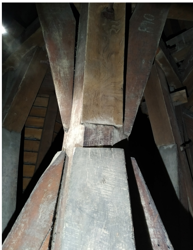
Assemblage des jambes de force et contrefiches sur le poinçon central, au-dessus de l'enrayure 9.
