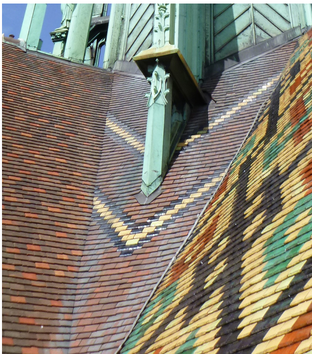
Pan sud-ouest : détail du motif en chevron et des bandes de recouvrement en zinc sous les parties en cuivre. Feuillard sur noue sud.
