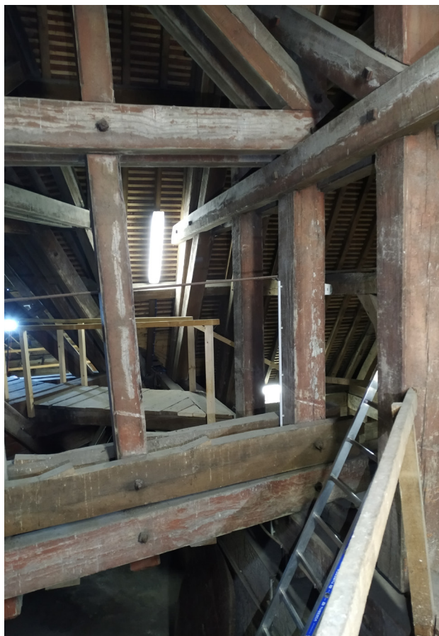
Demi-pan de bois nord : liaison avec la ferme périphérique nord, partie basse.
