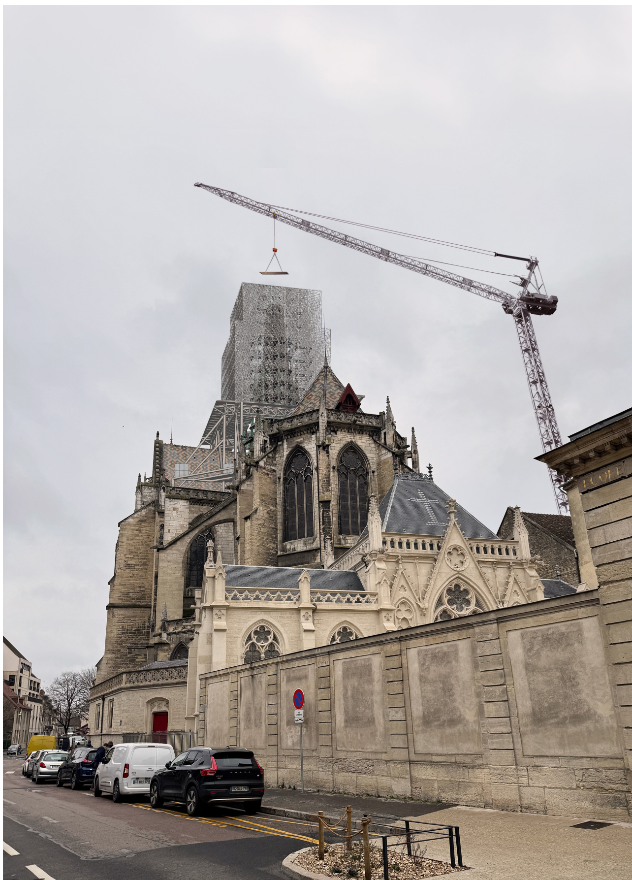
Vue des échafaudages de la flèche depuis la rue Michelet en cours de dépose ou de repose de la flèche : échafaudages mi-hauteur.
