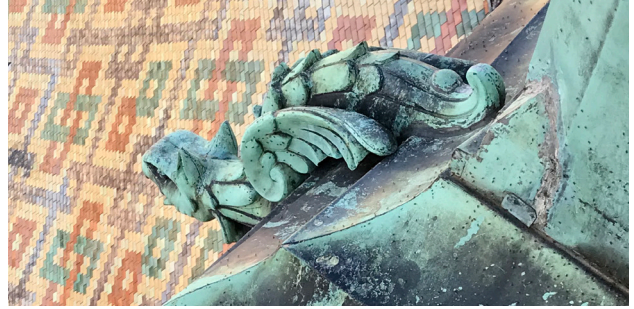
Détail de fixation des chimères boulonnées en partie haute.
