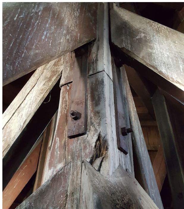
Enture en croix du poinçon entre les enrayures 3 et 4.
