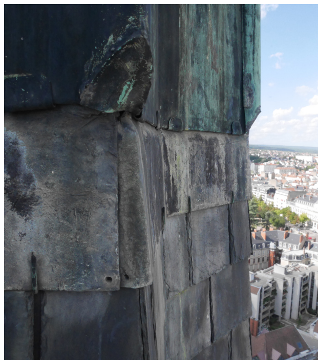
Bandes de recouvrement en plomb
