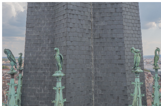
Couverture ardoise, partie basse, côté nord. Cliché pris par drone.
