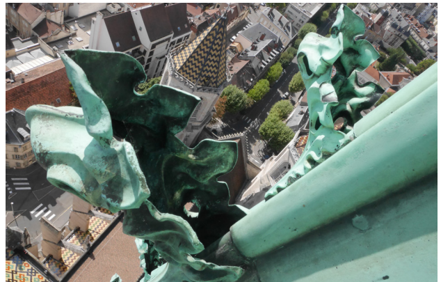
Détail des crochets de la partie supérieure de l'aiguille.
