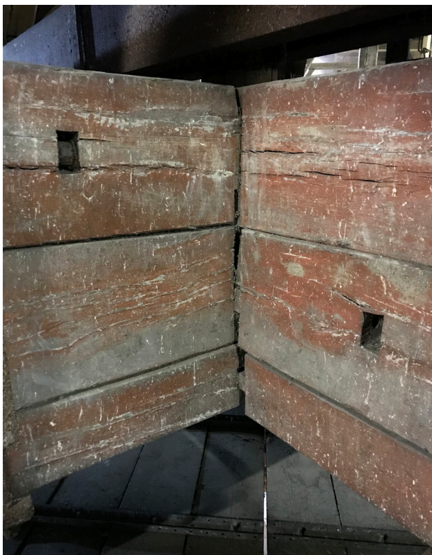
Jonction des entrails diagonaux : brin supérieur NO-SE continu, tenon boulonné sur NE-SO, et inversement sur le brin inférieur.
