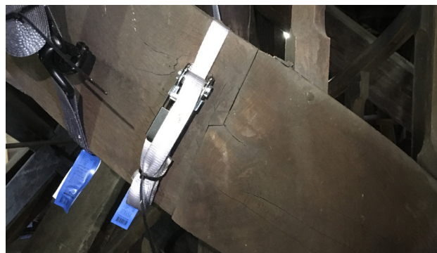
Assemblage du limon à crochet. Nœud dans la coupe à crochet, fente à l'axe.
