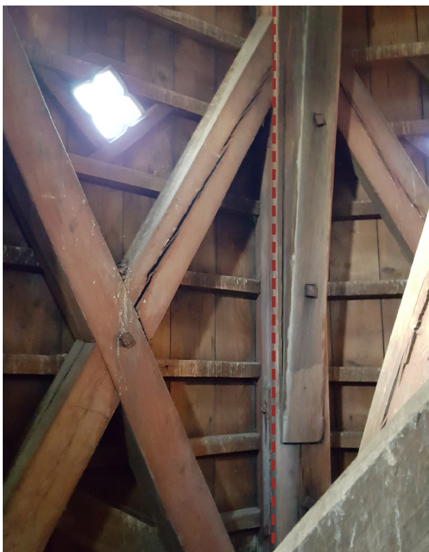
Poteau de fût nord-ouest encadré de croix de St-André formant le fût entre les enrayures 3 et 4.
