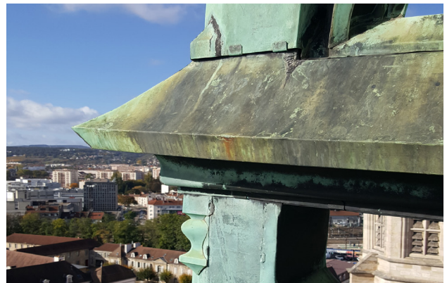
Détail des moulures rapportées sur le chanfrein des poteaux de contrefort.
