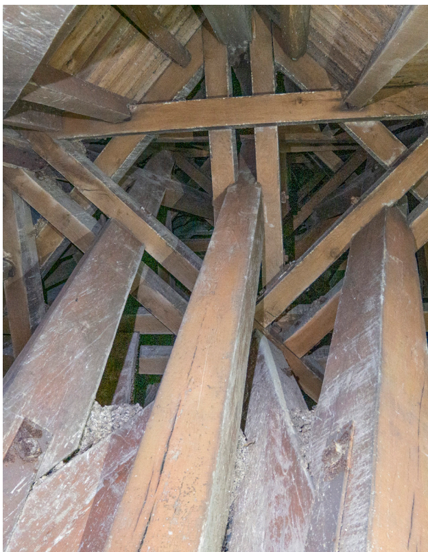
Vue de la charpente de l'aiguille depuis l'enrayure 6. Au premier plan, les jambes de force et contrefiches assemblées au poinçon.
