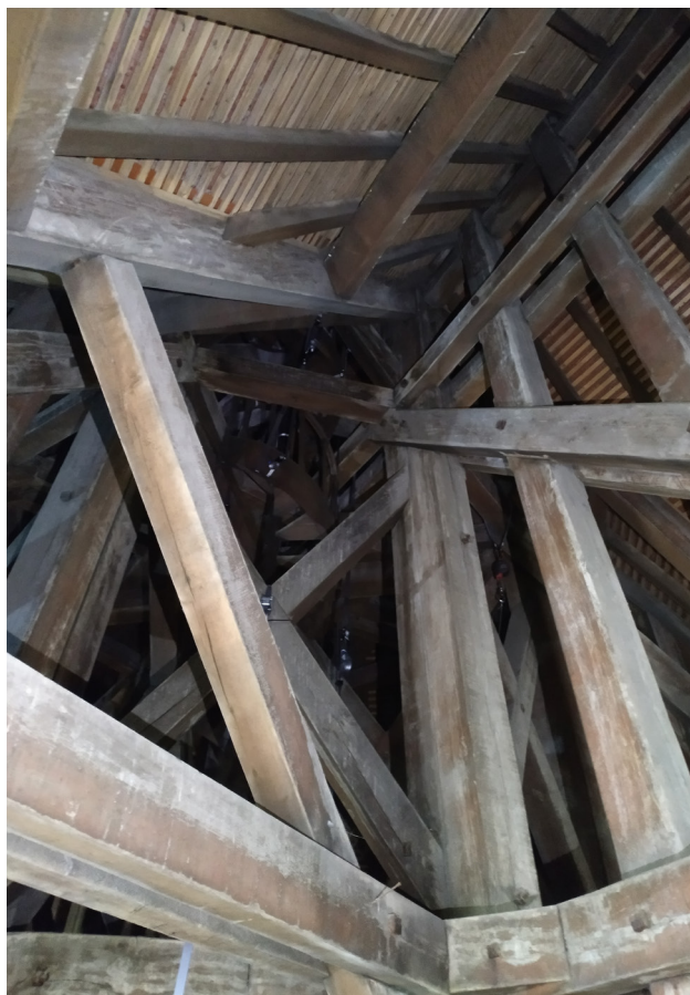
Pan de la noe SSO en liaison avec le demi-pan-de-bois d'axe sud.
