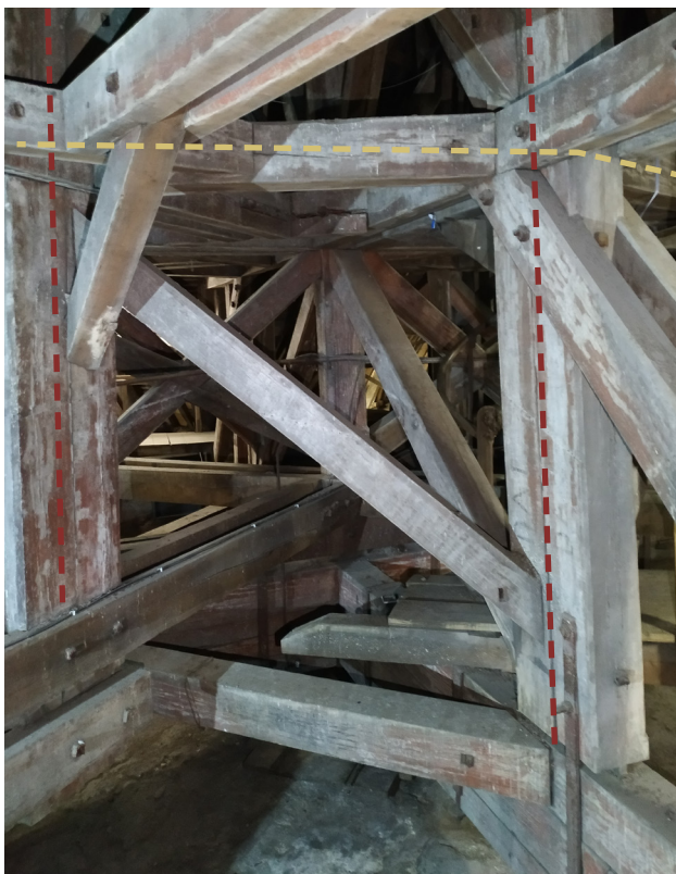
Vue de la face sud-sud-ouest du fût, entre les enrayures 1 et 2. Repérage des doubles-poteaux formant le fût.
