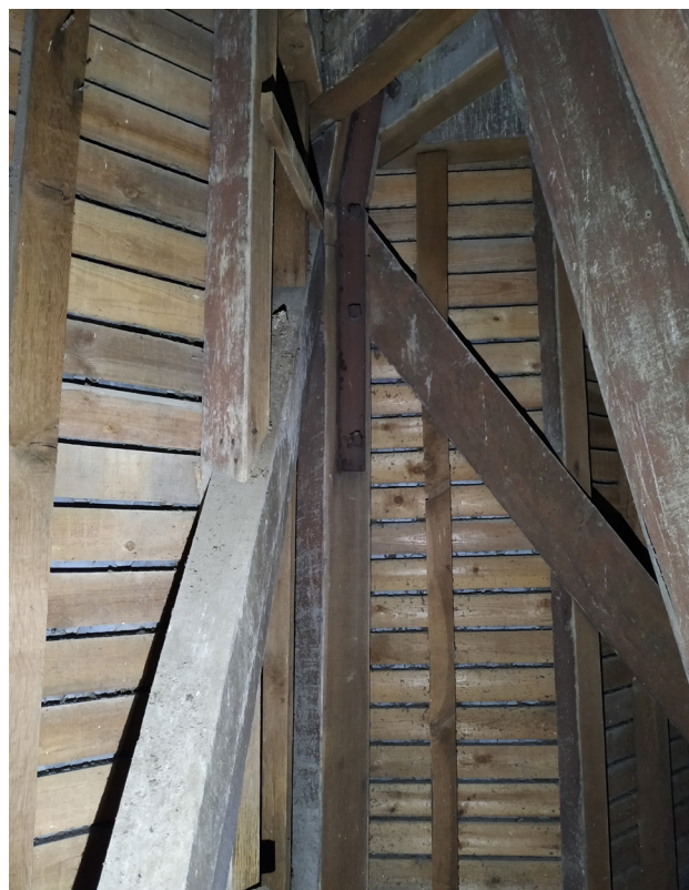
Contreventement des facettes de l'aiguille, au niveau de l'enrayure 6
