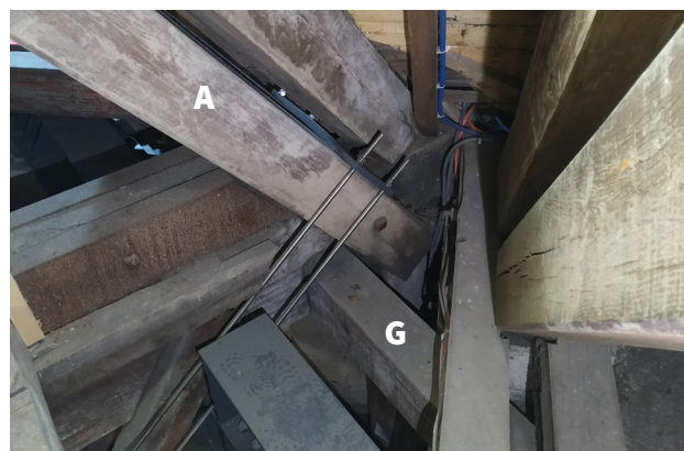
A/ Arbalétrier nord-ouest appuyé sur la poutre-entrait diagonale, DERRIÈRE le gousset G.
