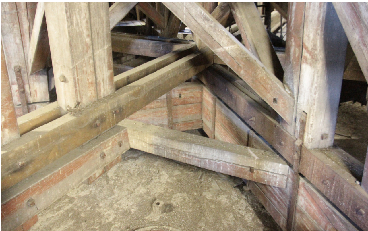
Assemblage des entrails et naissance du fût octogonal de la souche, depuis le sud. A gauche, moise en bois autour des demi-pan de bois d'axe rapportée en 1913. A droite, moise métallique de renforcement de l'entrait SE-NO, également rapportée en 1913.
