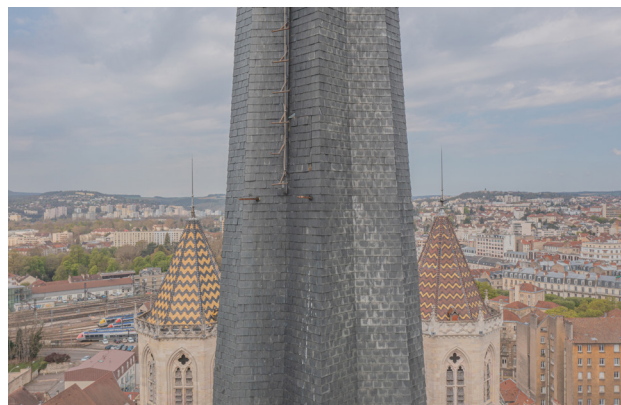
Couverture ardoise, partie basse, côté est. Démarrage de l'échelle de perroquet avec trappe d'accès. Cliché pris par drone.
