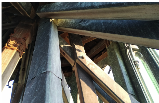
Recouvrement en cuivre sur trois faces des écharpes et jambes de force à l'air libre dans l'étage à claire-voie.
