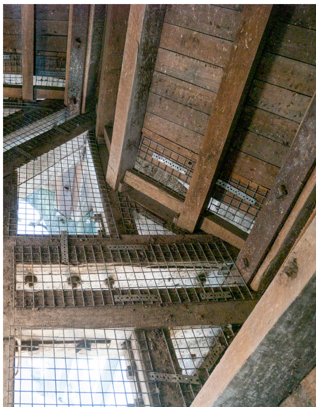
Litteauage périphérique de l'aiguille au niveau de l'enrayure 5, en forme d'étoile.
