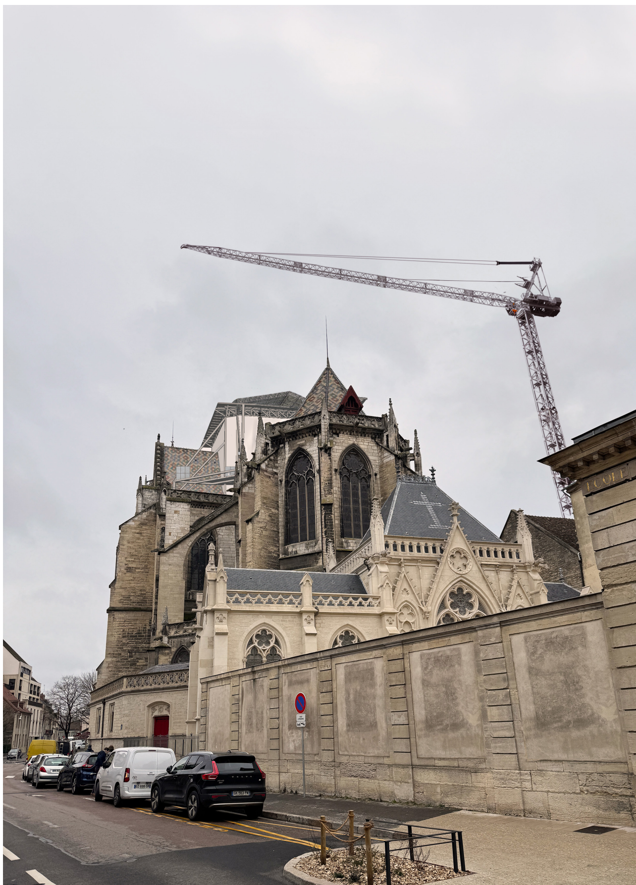
Vue des échafaudages pendant la tranche optionnelle 2 - Restauration de la flèche en atelier. La croisée sera couverte d'un parapluie et le tabouret métallique bâché.
