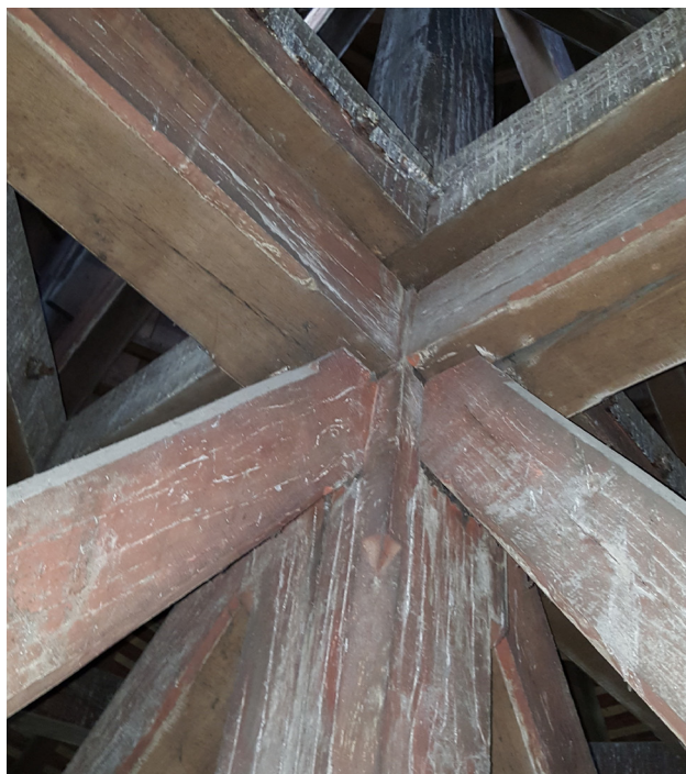
Poinçon au niveau de l'enrayure 2.
