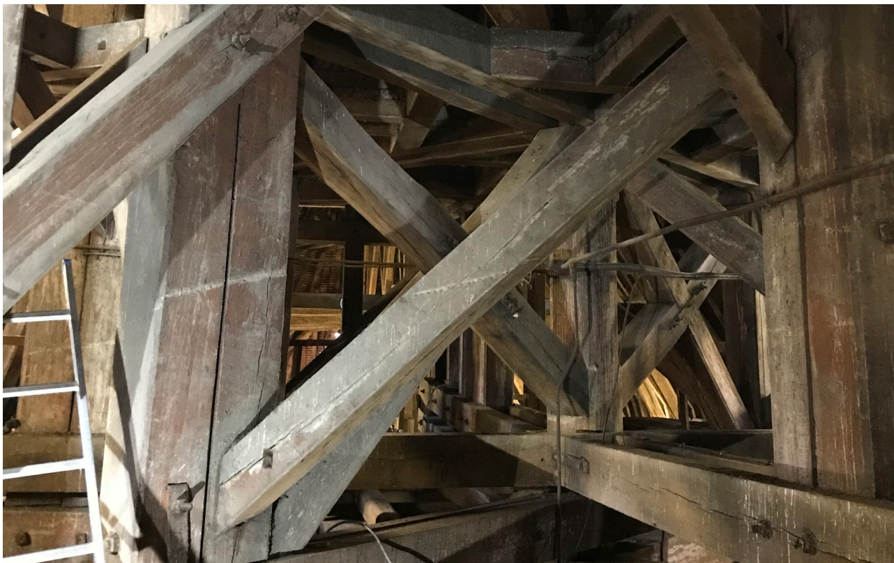
Vue de l'enrayure 1 en-bas et de l'enrayure 2 en-haut, poinçon en arrière-plan, doubles-poteaux de fût en premier plan. L'ensemble des pièces est recouverte de peinture rouge au minium de plomb. Les assemblages sont boulonnés.
