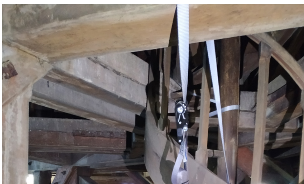
Interruption du limon au niveau du passage d'une enrayure
