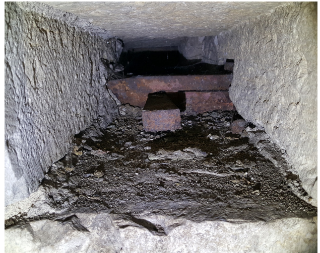
Lumière dans le mur bahut sur une clé de serrage du chaînage de la maçonnerie.
