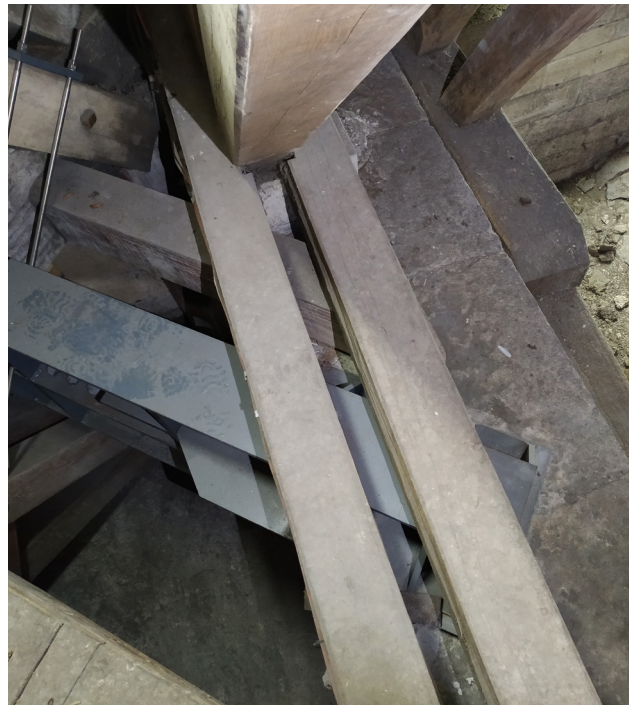
Appui de l'entrait de la ferme périphérique nord sur les goussets d'angle. Le métallique est celui installé en 2020 en renfort d'urgence.
