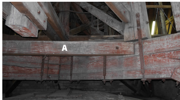
A/ Gousset ouest entre les poutres-entrails diagonales.
