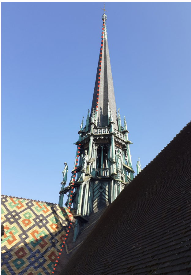
Repérage du cheminement du paratonnerre côté nord-ouest.
