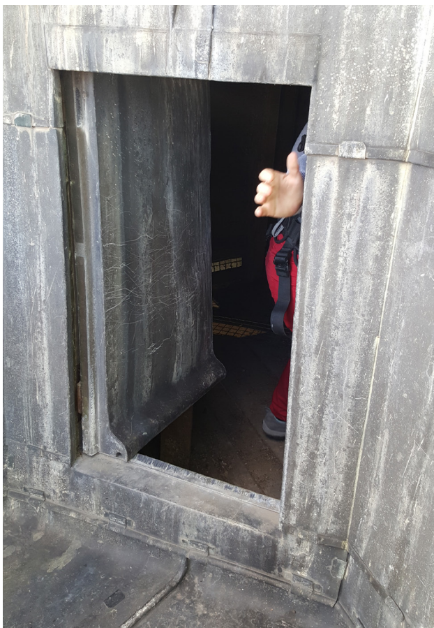
Porte d'accès à la galerie supérieure depuis la charpente de l'aiguille. Couverte de plomb.
