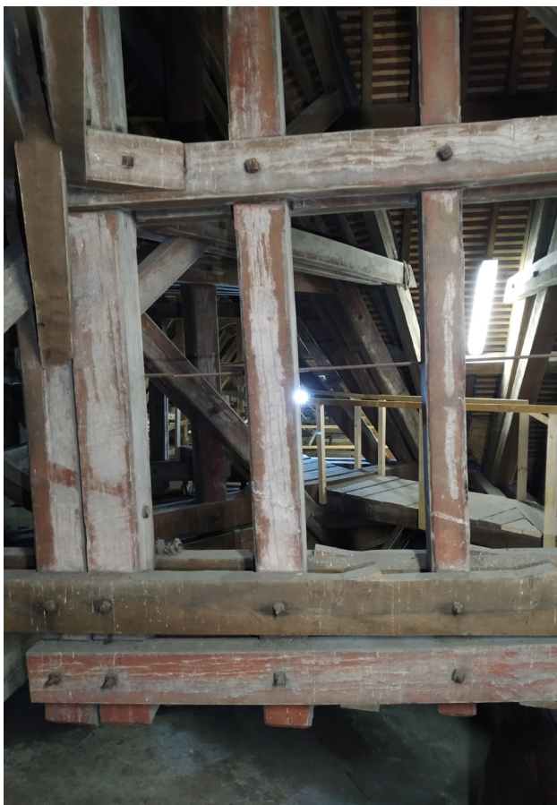
Demi-pan de bois nord, entre enrayures 1 et 2. De gauche à droite : double-poteau de fût, 1er poteau de contrefort, 2ème poteau de contrefort.
