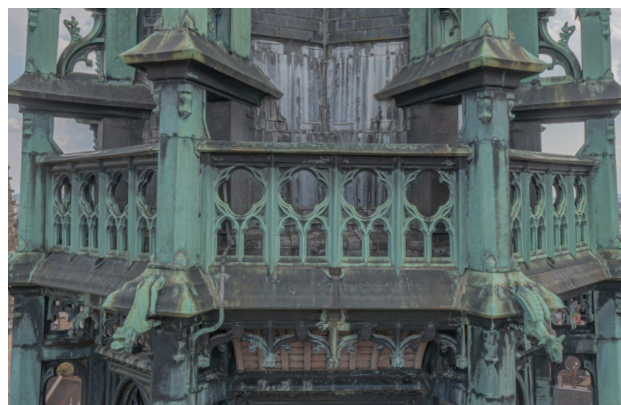
Garde-corps sur une des faces octogonales du sommet du réchaud : exutoire du chéneau de la galerie supérieure au pied du montant central. Cliché drone.
