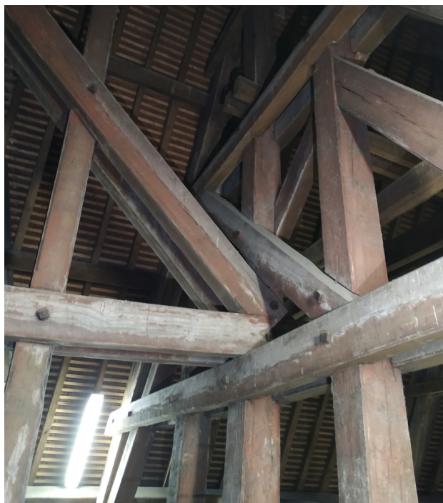
Demi-pan de bois nord : liaison avec la ferme périphérique nord, partie haute.
