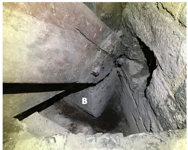
B/ Corbeau nord-ouest dégagé en octobre 2022, initialement appui du tabouret.
