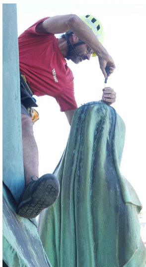
Statue de Sainte Chantal : capot en cours de dévissage pour endoscopie.
