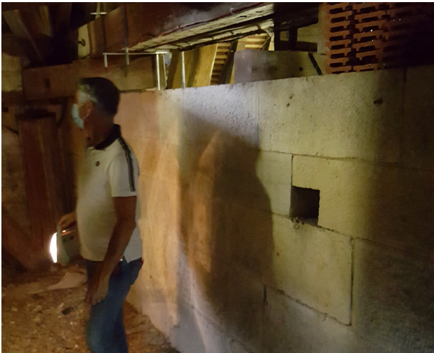
Mur bahut en pierre de taille, avec lumière d'accès aux clés de serrage des tirants périphériques.
