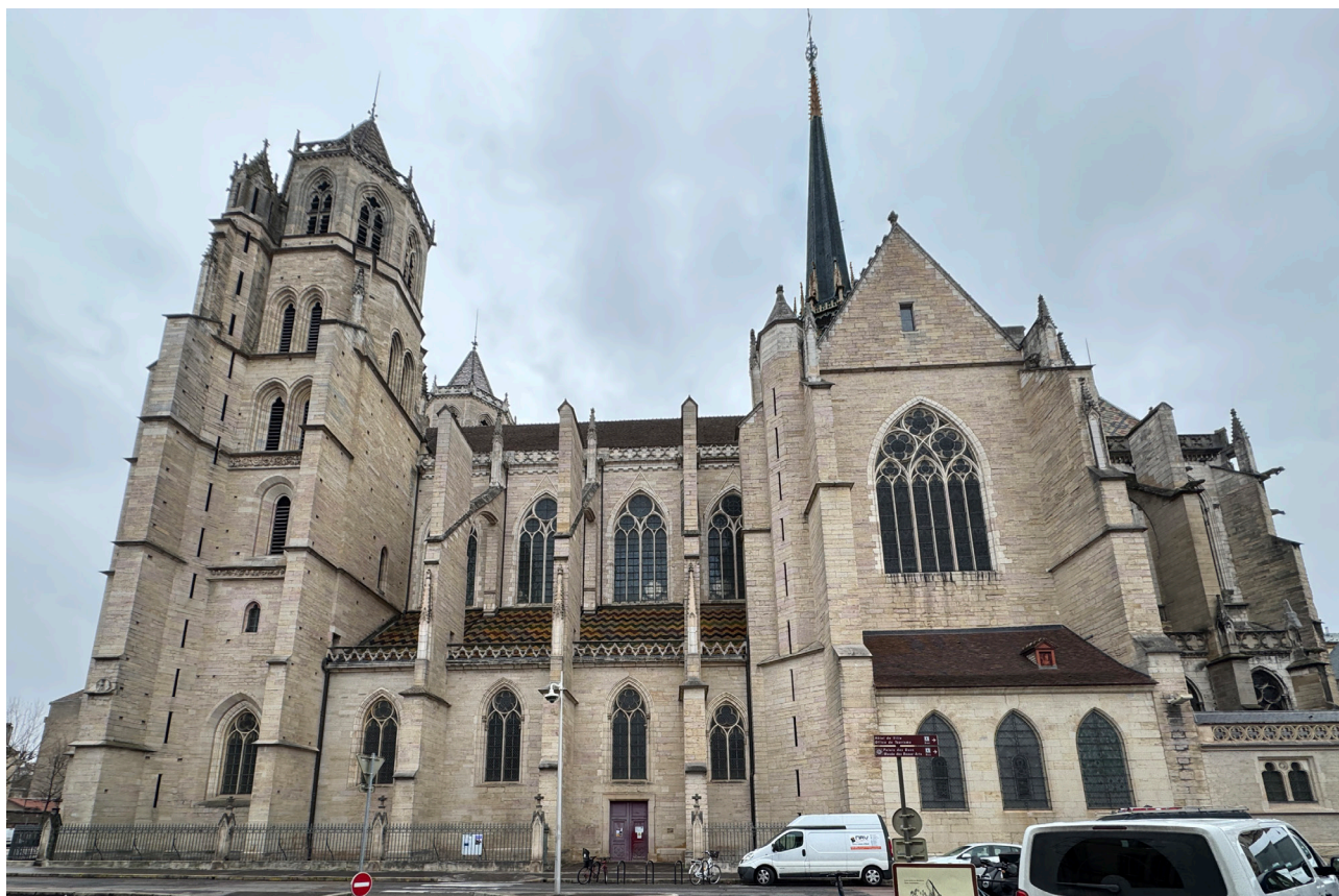
Vue projet de la façade sud de la cathédrale avec interventions extérieures de mise en sécurité quasi imperceptibles : exutoires, descentes feuillard, boîte à clé, mailles derrière abats-son des tours et sur étage ajouré de la flèche, pare-gravois en pied de toiture des tours. Seule la teinte des cuivres de la flèche sera modifiée.
