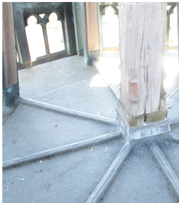
Terrasse en plomb de l'étage à claire-voie. Remontée d'étanchéité sur le poinçon central de la flèche.
