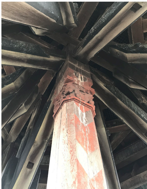
Assemblage des écharpes et des jambes de force sur le poinçon, sous l'enrayure 5, dans le réchaud. Traces de peinture en chevron sur le poinçon.
