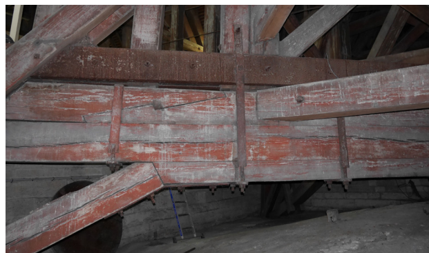
Poutre-entrait diagonale nord-ouest, composée de quatre brins bridés, de haut en bas : brin métallique de réparation, brin supérieur en bois, brin inférieur en bois, brin de butée des jambes de force.
