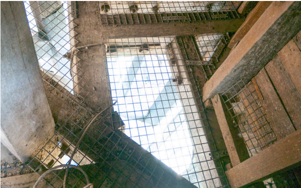
Trappe d'accès à l'aiguille depuis l'étage ajouré : un treillis soudé levable.
