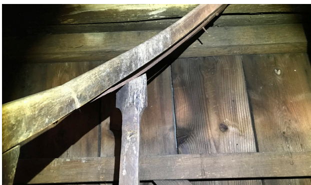
Main courante en tilleul, sur fer plat
