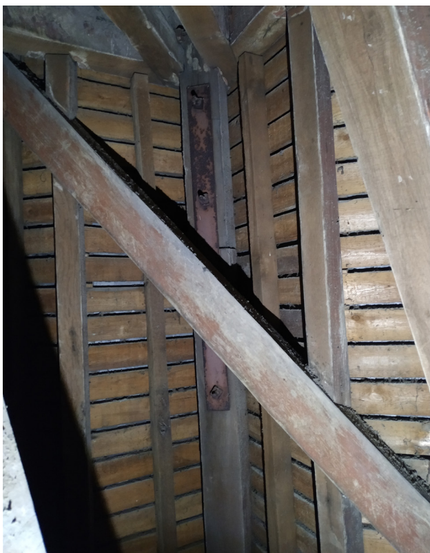
Contreventement des facettes de l'aiguille, au niveau de l'enrayure 8. En arrière-plan, l'enture d'un arêtier.
