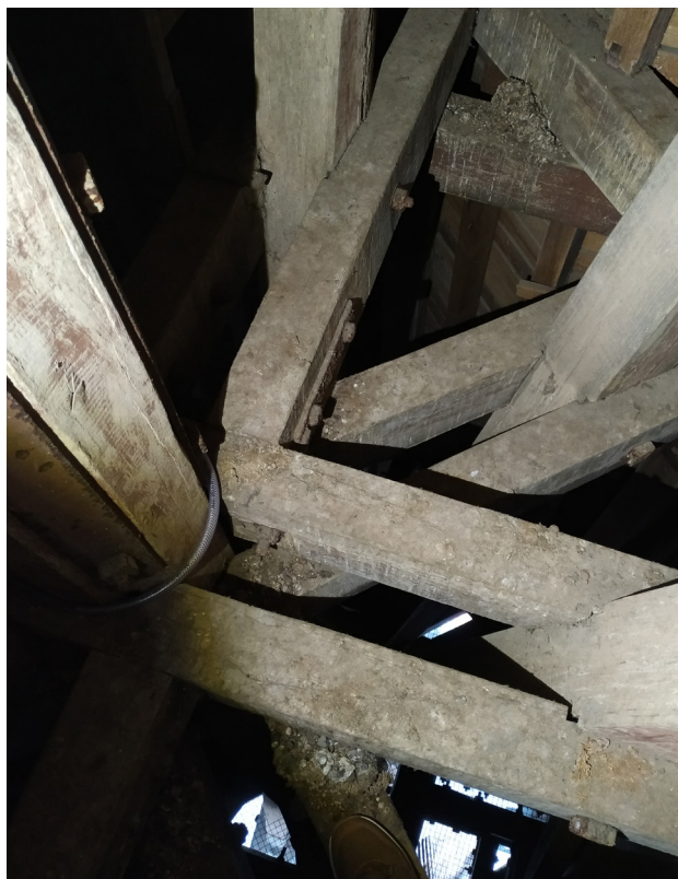
Superposition des enrayures du niveau 7, avec traversée des contrefiches et du poinçon.
