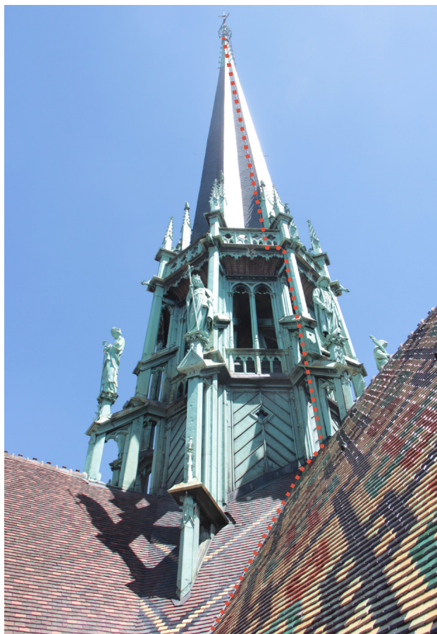
Repérage du cheminement du paratonnerre côté sud-ouest.
