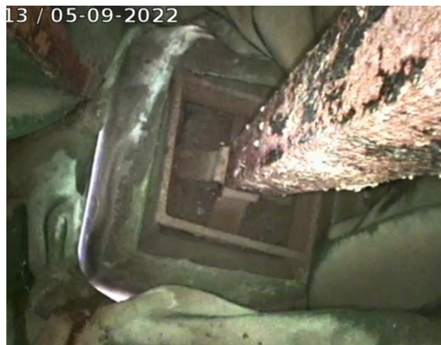
Statue NE de Jeanne de Chantal : Enfourchement sur le poteau. Cliché pris par endoscopie du 05/09/2022, ent. Trav'haut.
