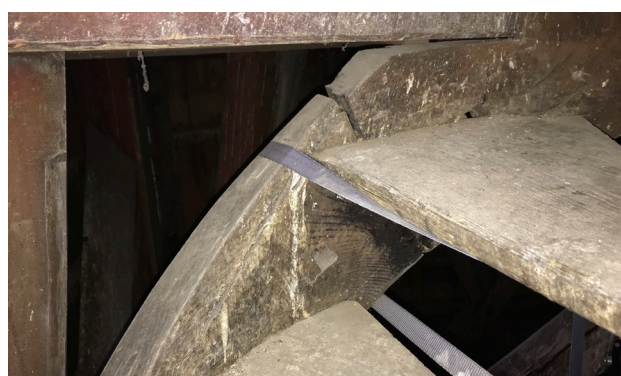
Assemblage du limon au droit d'une marche. Interruption du limon au niveau de l'enrayure.
