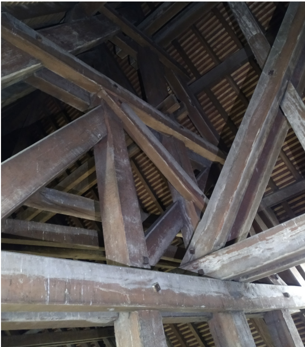
Ferme périphérique nord : liaison avec le demi-pan-de-bois d'axe.
