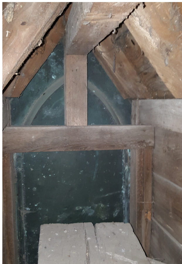
Vue intérieure de la lucarne nord-ouest. About d'entrait diagonal en-bas.
