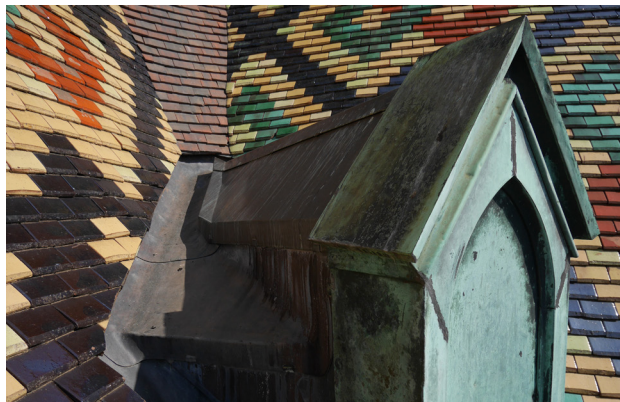
Détail de la couverture en zinc de la lucarne sud-est.
